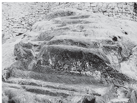
Obr. 5. Hrad Frýdštejn, okr. Jablonec nad Nisou. Stopy vodorovného základu neidentifikované stavby přisekané do pískovcového podloží. Foto F. Gabriel.
