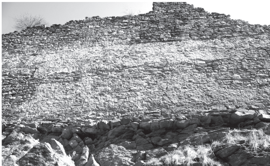
Obr. 3. Hrad Opárno, okr. Litoměřice. Založení hradby na zvětralé pararule. Foto L. Kursová.
