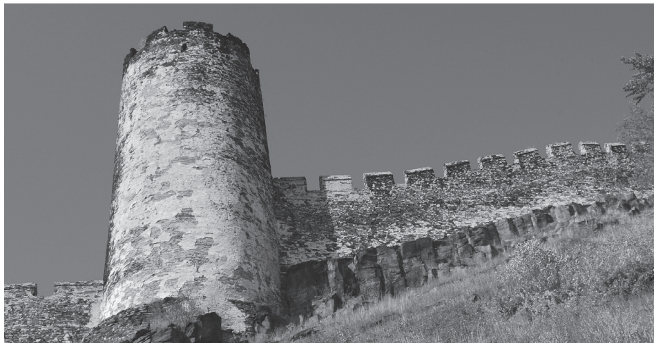
Obr. 2. Hrad Bezděz, okr. Česká Lípa. Založení hradby na znělcovém podloží. Foto I. Peřina.
