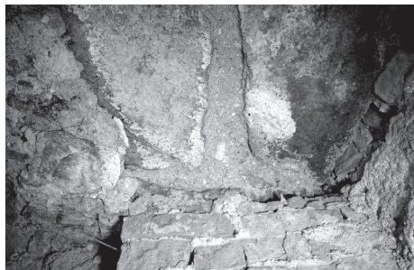
Obr. 9. Hrad Grabštejn, okr. Liberec. Mohutné lámané granodioritové desky spojené hrubou vápennou maltou. Foto I. Peřina. Abb. 9. Burg Grafenstein (Grabštejn), Bezirk Liberec. Mächtige Granodioritbruchplatten, die durch groben Kalkmörtel miteinander verbunden wurden. Foto I. Peřina.
