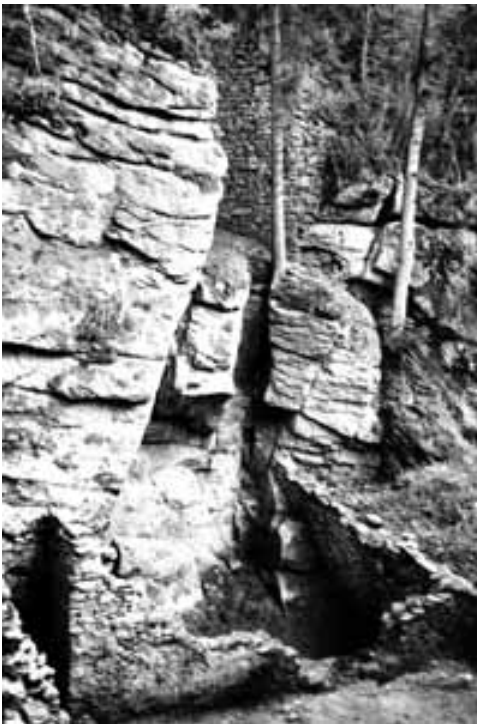
Obr. 18. Zachované zdivo budovy č. 2 s výstupovým koridorem v jižní stěně. Pohled od severu.
