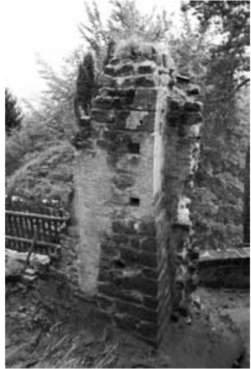
Obr. 3. Valdštejn (okr. Semily). Nároží stavby s kvádry rytými v omítce, v rozšířeném opěráku kapsa se zarážkou po dolním systému výztuh. Foto I. Peřina, 2007. Abb. 3. Valdštejn (Bez. Semily). Ecke des Bauwerks mit im Putz eingeritzten Quadern, die an der Nordseite den Vorhof der Hauptburg abgrenzt, im erweiterten Strebepfeiler Tasche mit Sperre des unteren Versteifungssystems. Foto I. Peřina, 2007.
