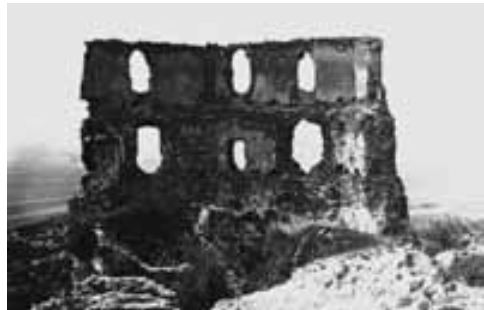
Obr. 6. Cimburk u Městečka Trnávky. Severní torzo před konzervačními zásahy s částečně vykopaným přízemím západního křídla počátkem 20. století. Foto archiv NPÚ, ú. o. p. v Brně. Abb. 6. Cimburk bei Městečko Trnávka. Nordtorso vor Konservierungseingriffen mit teilweise freigelegtem Erdgeschoss des Westflügels zu Beginn des 20. Jhdts. Foto Archiv des Nationalen Denkmalamts, Bezirksstelle Brno.
