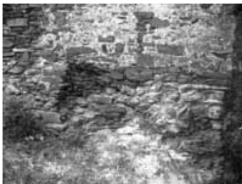
Obr. 12. Cimburk u Městečka Trnávky. Severovýchodní nároží jádra se začleněným starším zdivem, převrstveným pozdně gotickými, v nároží provázanými zdívy severního a východního křídla. Foto J. Štětina, 2007.
