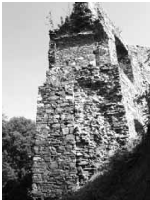
Obr. 8. Cimburk u Městečka Trnávky. Spára dělicí raně gotickou hradbu (vpravo) od mladšího pilíře. Foto J. Štětina, 2007.
