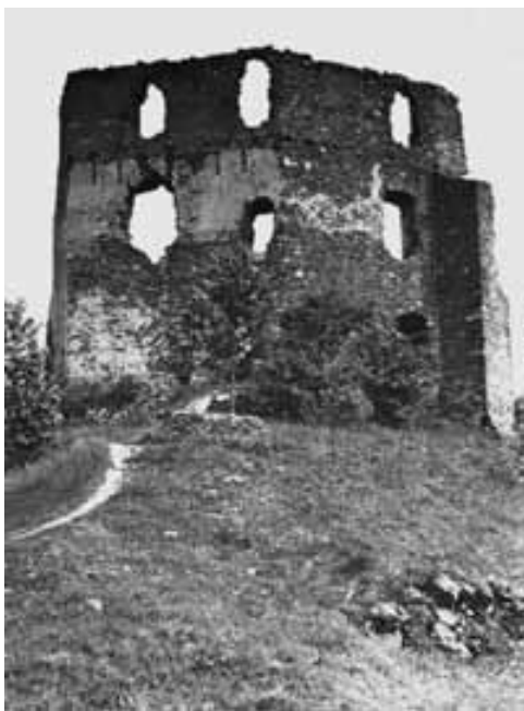
Obr. 11. Cimburk u Městečka Trnávky. Vnější průčelí severního obvodu jádra s patrnými stopami dřevěného ochozu počátkem 20. století. Foto archiv NPÚ, ú. o. p. v Brně.
