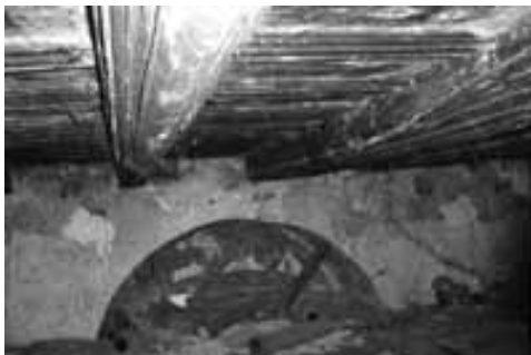
Obr. 3. Hruškově profilovaný trámový strop v mezipatře nosislavské tvrze – na pravém obrázku zbytky původní malby stropu, vlevo pod stropem klenby původního okenního otvoru v severní zdi.
