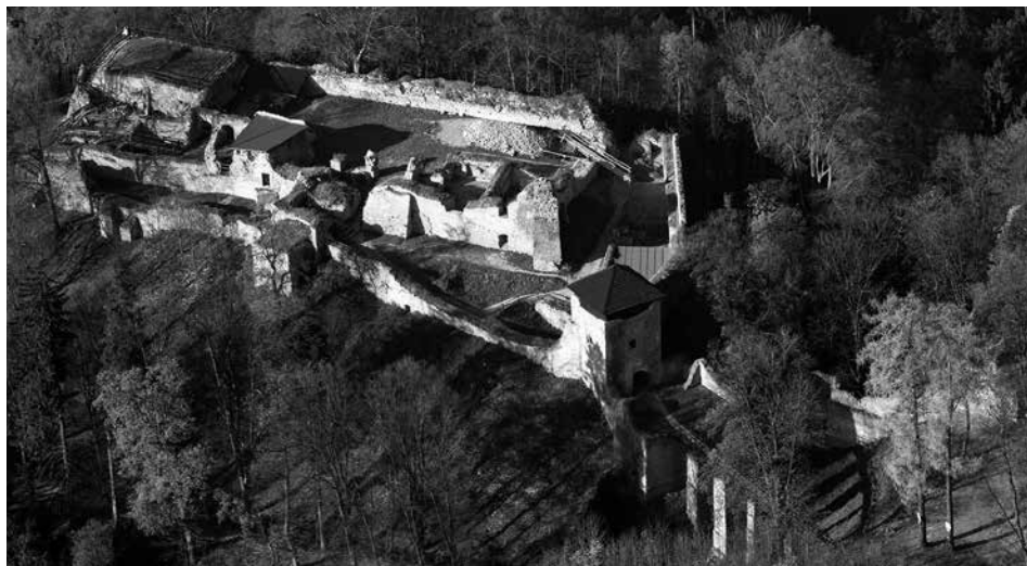
Obr. 1. Hrad Lukov, k. ú. Lukov, okr. Zlín. Letecký pohled na areál hradního jádra od jihovýchodu; jde o nejvýznamnější objekt ve Zlínském kraji, na kterém probíhají průzkumné a záchranné práce dlouhodobě. Konzervační a sanační práce zde postupují pomalým tempem a jejich výsledky jsou velmi cenným metodickým přínosem, na který už bylo v minulosti poukázáno (Vrla 2004, aktuální zhodnocení se zpracovává). Foto P. Baklík, 2011, archiv Spolku přátel hradu Lukova.
