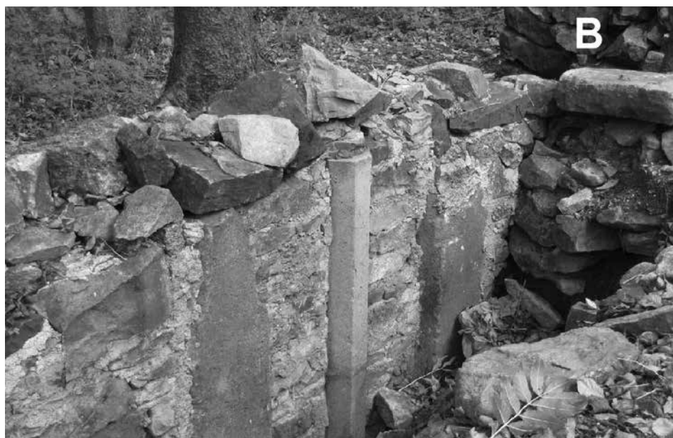
Obr. 6. Šaumburk, k. ú. Rajnochovice, okr. Kroměříž. A – fotografie situace kolem odkrytého torza raně gotického okna v severním paláci hradu, pohled od jihu (Kohoutek, 80. léta 20. století). B – tatáž partie po konzervaci a vložení ochranné zaddivky, pohled od jihozápadu (Vrla 2009).
