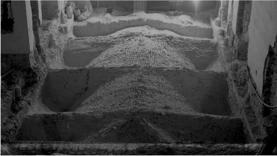
Obr. 7. Hrad Špilberk. Rub žebrové klenby přízemního gotického sálu ve východním křídle. Foto K. Šabata. Abb. 7. Burg Spielberg. Oberseite des Kreuzrippengewölbes des gotischen Saales im Ostflügel. Foto K. Šabata.
