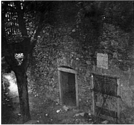
Obr. 4. Rabštejnek, k. ú. Smrkový Týnec, okres Chrudim. Pohled od severu na nádvorní zeď zastřešené romantické vestavby. Vlevo dole je patrný zaklenutý vstup do hradního areálu. Stav z roku 1959. Fotografie ze sbírky M. Vorla.
