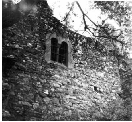
Obr. 5. Rabštejnek, k. ú. Smrkový Týnec, okres Chrudim. Pohled na západní stranu hradního jádra. V prostoru mezi dvěma opěráky se nalézá zamřížované pseudorománské okénko. Stav z roku 1959. Fotografie ze sbírky M. Vorla.
