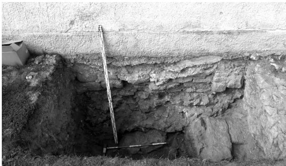
Obr. 10. Zemplín, reformovaný kostol. Sonda S7/14, základové murivo románskeho kostola a tzv. babinca stojace na skalnom geologickom podloží v miestach prerazeného gotického vstupu do kostola. Foto A. Balogh.
