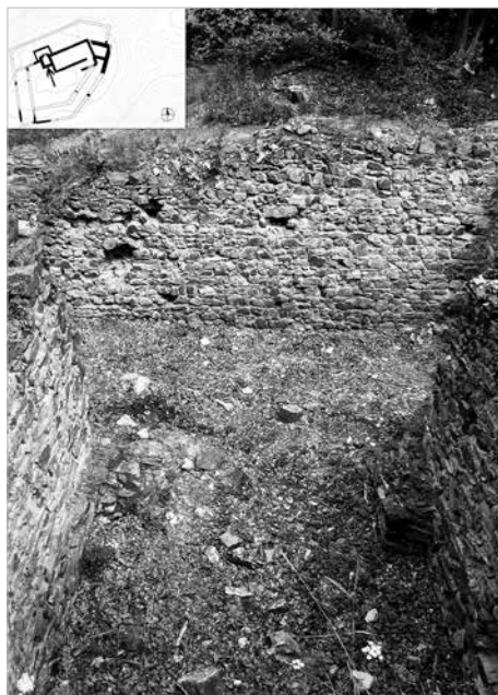
Obr. 17. Nový hrad u Kunratic. Srovnávací foto k obr. 16, stav objektu před zahájením rekonstrukčních prací v roce 2012. Foto F. Flek, NPÚ.
