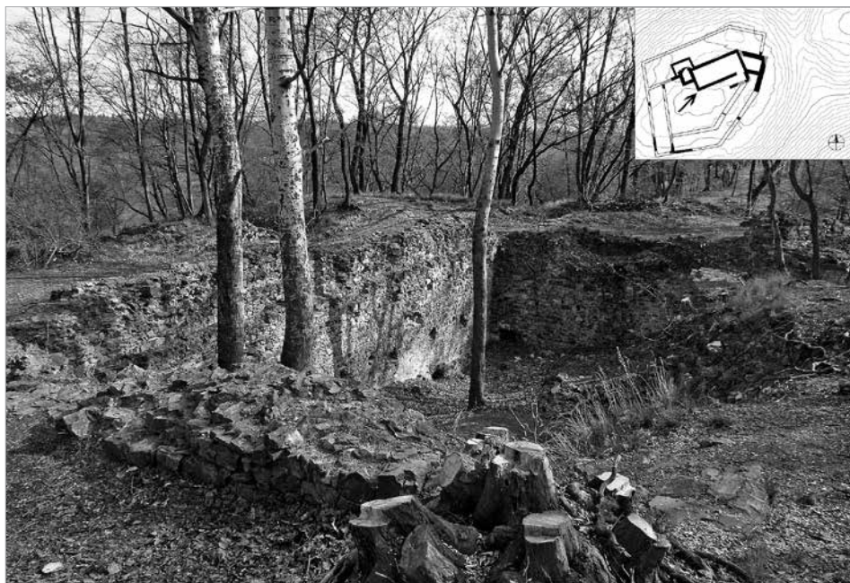
Obr. 9. Nový hrad u Kunratic. Srovnávací foto k obr. 8, stav objektu před zahájením rekonstrukčních prací v roce 2012. Foto F. Flek, NPÚ. Abb. 9. Wenzelsburg bei Kundratitz. Vergleichsfoto zu Abb. 8, Zustand des Objektes vor Beginn der Rekonstruktionsarbeiten im Jahr 2012. Foto F. Flek, Nationalinstitut für Denkmalpflege.
