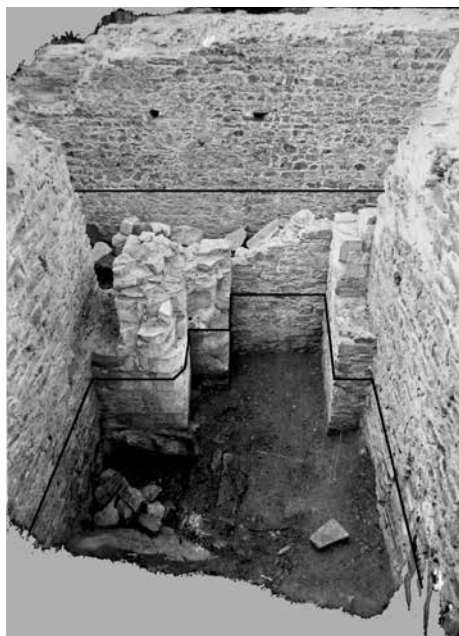
Obr. 16. Nový hrad u Kunratic. Podzemní prostor tzv. vlčí jámy pod průjezdem druhé brány, pohled od jihu. Stav při jeho odhalení v letech 1928 a 1929. Černou čarou vyznačena úroveň dnešního terénu. ARÚ AV ČR, Praha, FT000081716.
