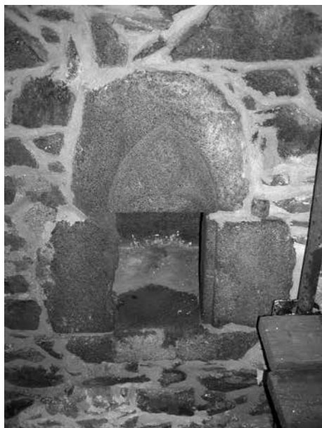
Obr. 4. Rokštejn, k. ú. Panská Lhota, město Brtnice. Výklenek sanktuáře po spárování. Foto L. Kundera. Abb. 4. Rokštejn, Katastergebiet Panská Lhota, Stadt Brtnice. Nische des Sanktuariums nach Ausfugung. Foto L. Kundera.
