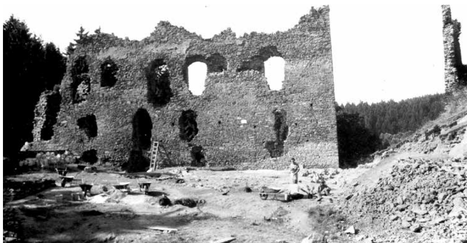
Obr. 5. Rokštejn, k. ú. Panská Lhota, město Brtnice. Východní nádvoří průčelí dolního paláce v roce 1983. Foto M. Plaček. Abb. 5. Rokštejn, Katastergebiet Panská Lhota, Stadt Brtnice. Östliche Hoffassade des unteren Palas im Jahr 1983. Foto M. Plaček.
