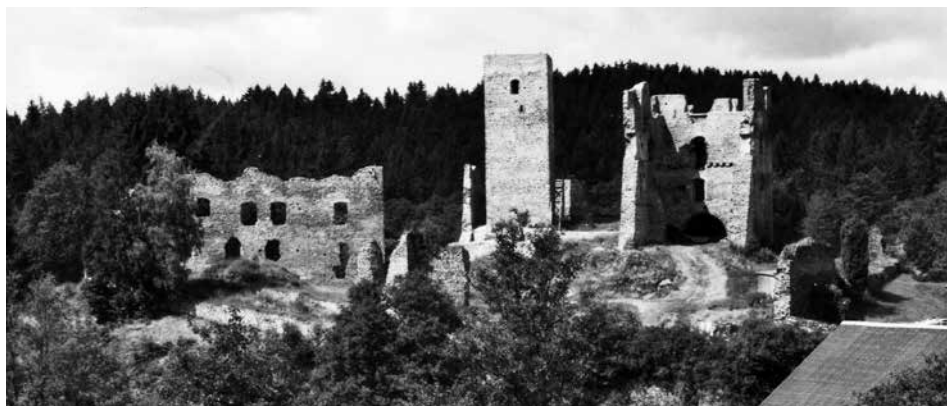
Obr. 8. Rokštejn, k. ú. Panská Lhota, město Brtnice. Pohled na věž a palác horního hradu a palác dolního hradu od východu po provedení většiny zabezpečovacích v roce 2012. Foto M. Plaček.
