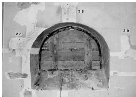
Obr. 13. Kopčany, okr. Senica, Kostol sv. Margity Antiochijskej. Zaniknuté termálne okno s výzdobou. Abb. 13. Kopčany, Bezirk Senica, Kirche St. Margaretha von Antiochien. Entferntes Thermalfenster mit Verzierung.
