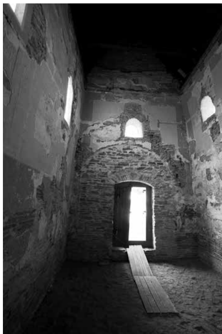
Obr. 5. Kopčany, okr. Senica, Kostol sv. Margity Antiochijskej. Západná stena po čiastkovej obnove. Abb. 5. Kopčany, Bezirk Senica, Kirche St. Margaretha von Antiochien. Westwand nach teilweiser Restaurierung.
