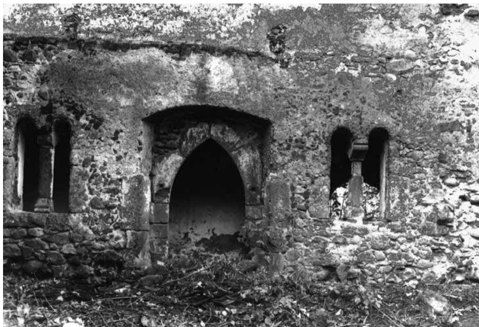
Obr. 8. Bzovík, západná stena kapitulnej siene so sekundárne vloženými románskymi združenými oknami, stav v medzivojnovom období. Foto Archív Pamiatkového úradu SR, Zbierka negatívov, fond 1. ČSR, sign. 20637. Abb. 8. Bzovík, Westwand des Kapitelsaals mit sekundär eingefügten verbundenen Fenstern, Zustand in der Zwischenkriegszeit. Foto Archív des Slowakischen Denkmalmates, Fotonegativsammlung, Bestand 1. ČSR, Sign. 20637.
