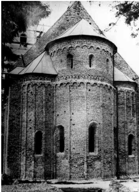
Obr. 6. Diakovce, niekdajší kláštorný Kostol Panny Márie, obnažené tehlové murivo východných apsid počas obnovy v rokoch 1939–1940. Foto Archív Pamiatkového úradu SR, Zbierka negatívov, sign. 5749.
