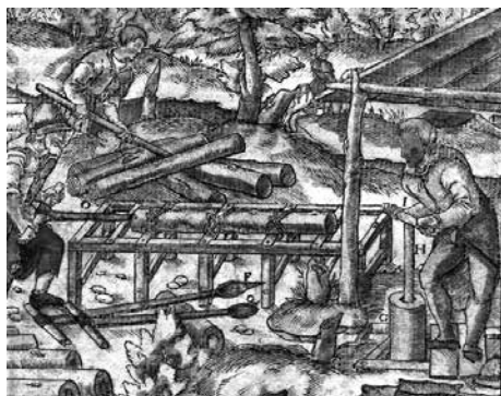
Obr. 12. Vrtanie rúr pre banské pumpy. Podľa Agricola 1557. Abb. 12. Arbeiter beim Röhrenbohren für Grubenpumpen. Nach Agricola 1557.
