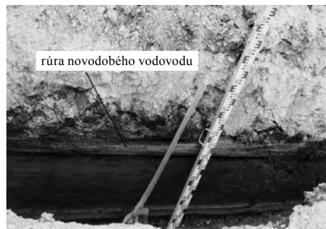
Obr. 15. Banská Bystrica. Námestie Š. Moysesa. Detail poškodeného dreveného vodovodu. Foto M. Mácelová.
