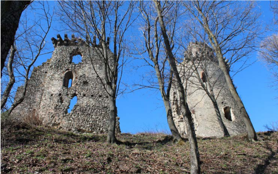
Obr. 14. Hrad Slanec, okr. Košice-okolie. Celkový pohľad na jadro s vežou a severovýchodnou stenou paláca so zachovaným murivom pôvodnej hradby. Foto M. Šimkovic.
