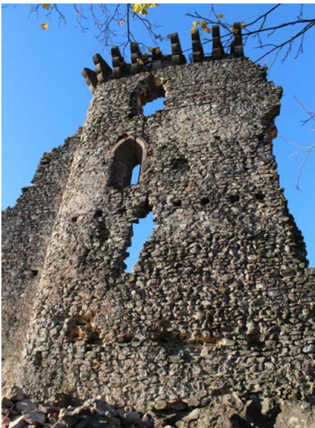
Obr. 15. Hrad Slanec, okr. Košice-okolie. Celkový pohľad na severovýchodný úsek steny paláca so zachovaným murivom pôvodnej hradby. Foto M. Šimkovic.
