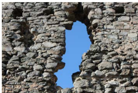
Obr. 16. Hrad Slanec, okr. Košice-okolie. Detail severovýchodnej steny paláca so zvyškom okna a lôžkami stropu pôvodnej budovy. Foto M. Šimkovic.
