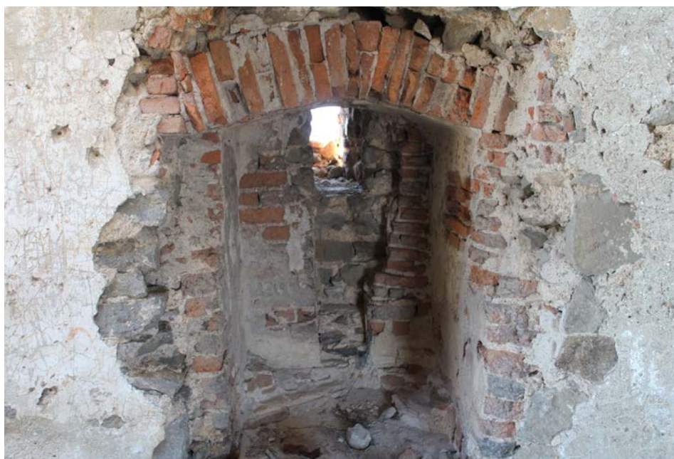
Obr. 13. Hrad Slanec, okr. Košice-okolie. Pôvodné okno na druhom podlaží veže. Foto M. Šimkovic. Abb. 13. Burg Slanec, Bez. Košice-Umland. Ursprüngliches Fenster im zweiten Turmstockwerk. Foto M. Šimkovic.
