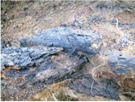
Obr. 5. Křížení trámů vnějších stěn 305 a 307 dřevohlinité bašty.
