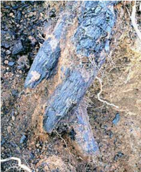
Obr. 6. Křížení trámů vnitřních stěn 304 a 305 dřevohlinité bašty.
