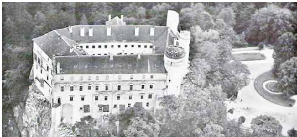
Obr. 3. Hrad Orlík, okr. Písek. Letecký pohled od severozápadu z počátku 20. let minulého století.
