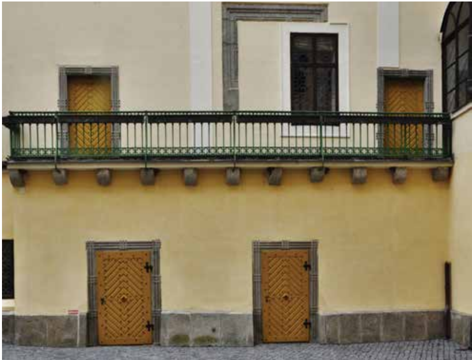
Obr. 14. Hrad Orlík, okr. Písek. Nádvoří průčelí severozápadního křídla s pozdně gotickými portálky a analyticky přiznaným ostěním okna. Foto J. Varhaník, 2017. Abb. 14. Burg Orlík, Bezirk Písek. Hoffassade des Nordwestflügels mit kleinen spätgotischen Portalen und analytisch anerkannten Fensterlaibungen. Foto J. Varhaník, 2017.
