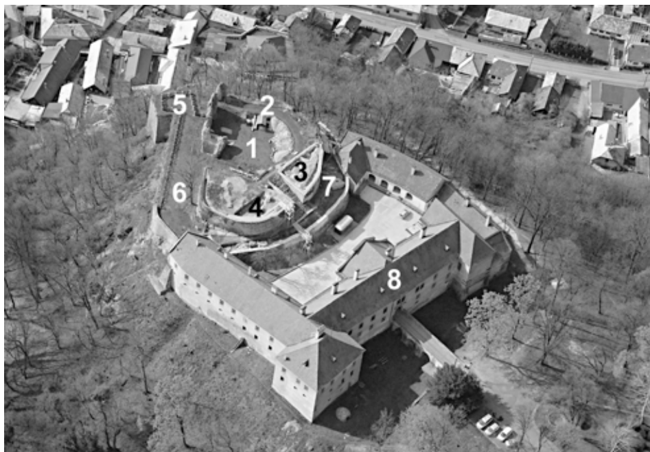
Obr. 2. Hrad Modrý Kameň, okr. Veľký Krtíš. Letecká snímka z roku 2014. Vyznačené sú hlavné hradné objekty. 1 – nádvorie horného hradu, 2 – západné krídlo paláca, 3 – valcová veža, 4 – severovýchodná terasa s hradnou kuchyňou, 5 – bastión, 6 – východný parkán, 7 – severný parkán (stredný hrad), 8 – barokový kaštieľ na mieste dolného hradu. Foto J. Beljak.
