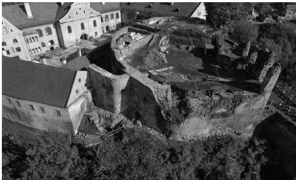
Obr. 12. Hrad Modrý Kameň, okr. Veľký Krtíš. Západná línia opevnenia hradného jadra s výskumom odkrytou architektúrou západného a juhozápadného krídla paláca v roku 2015. Foto J. Ornth.
