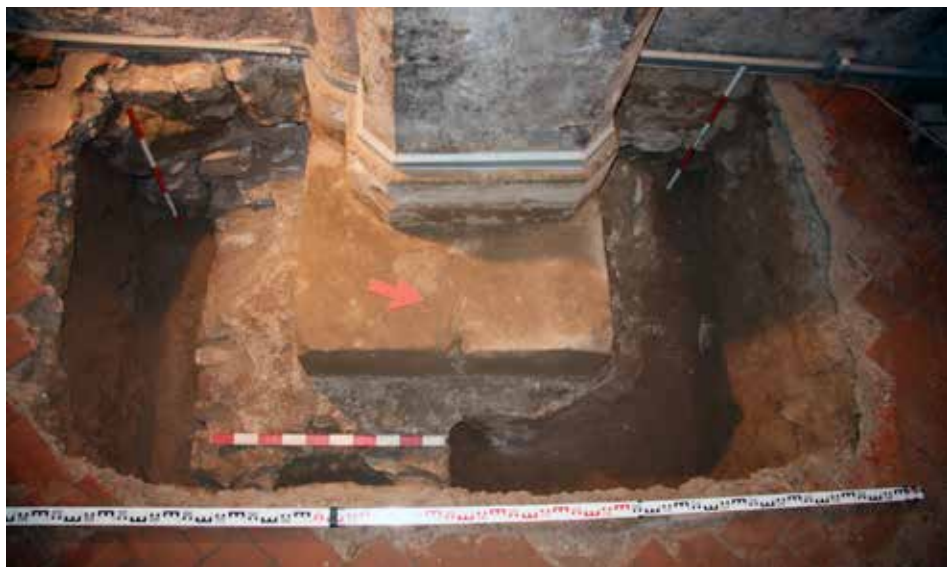
Obr. 5. Sonda S3/13 – základové murivo JZ rohu pôvodnej lode aj so zvyškami osekaného oporného piliera. Foto A. Balogh. Fig. 5. Test pit S3/13 – masonry foundations of the SW corner of the original nave with remains of a supporting pillar. Photo A. Balogh.
