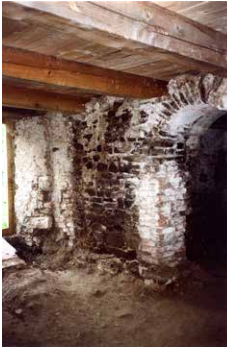
Obr. 15. Pohled od severu na boční vstup ve spojovací příčce. Foto B. Nechvátal. Abb. 15. Blick von Norden auf den Seiteneingang in der Verbindungstrennwand. Foto B. Nechvátal.
