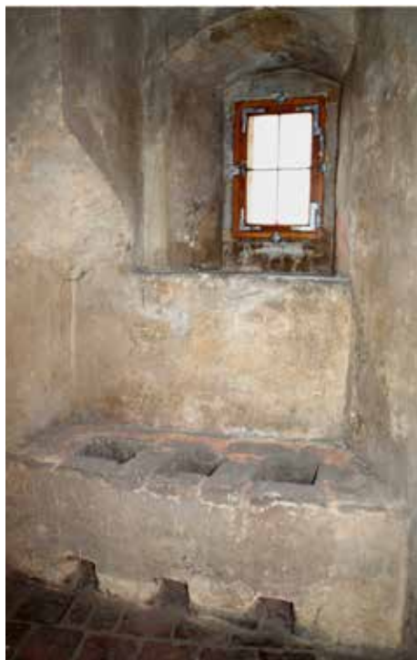
Obr. 3. Topeniště s šachtami v pátém podlaží Ludvíkova křídla. Foto M. Cejmová. Abb. 3. Feuerstätte mit Schächten im fünften Stockwerk des Ludwigsflügels. Foto M. Cejmová.
