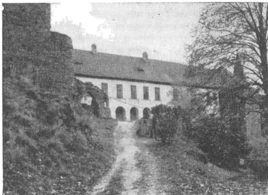
Obr. 3. Velhartice – Huertovo křídlo od SZ. Vlevo starý palác a zbytek gotické brány horního hradu. Foto P. Znamenany.
