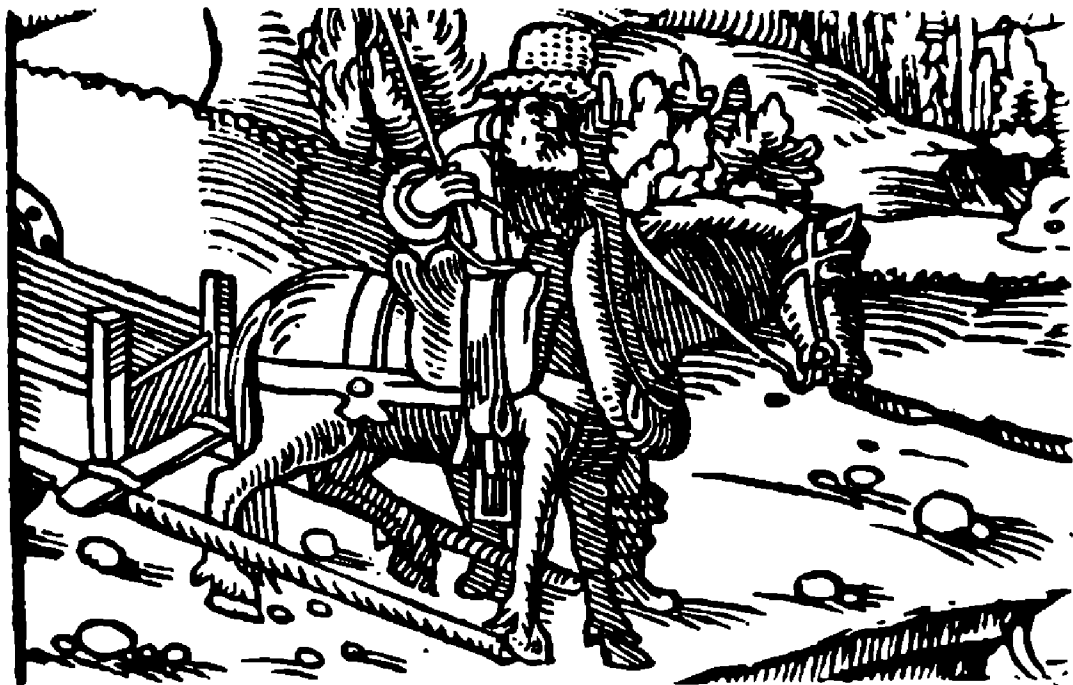
Obr. 13. Vůz ze 16. století tažený za oje a brzděný opěrákem.
