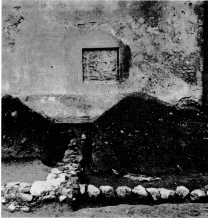
Obr. 17. Zvyšky muriva prístavieb na severovýchodnom trakte kaštieľa. Foto E. Rejholec.
