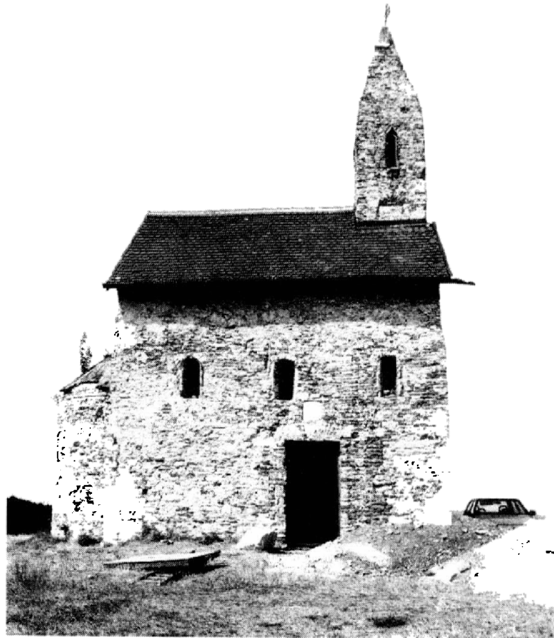
Obr. 1. Nitra-Dražovce. Kostol sv. Michala, stav v priebehu historicko-architektonického výskumu (1993). Foto A. Ruttkay.
