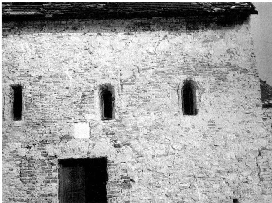
Obr. 3. Časť južnej fasády po odstránení omietok. Foto archív SPÚ.
