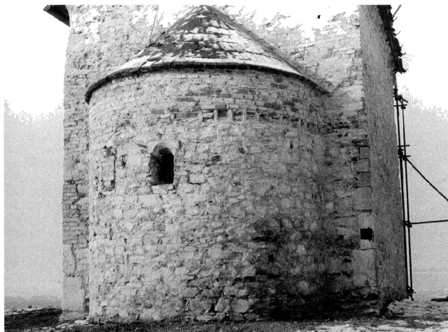
Obr. 4. Apsida po odstránení omietok. Foto archív SPÚ.
