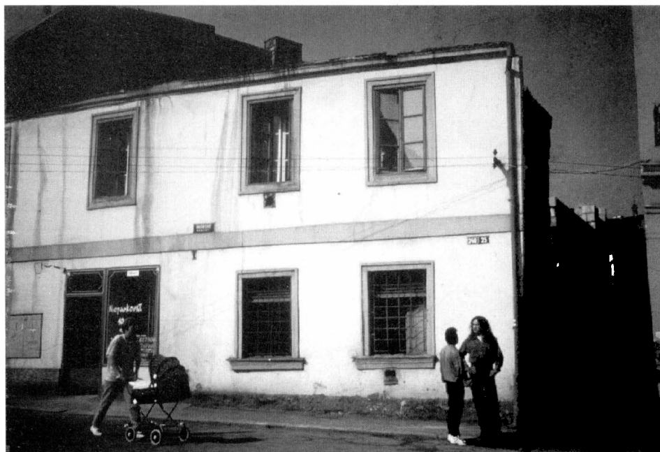
Obr. 3. Stav čp. 340 na Anenském náměstí během probíhajících úprav v létě 1996.
