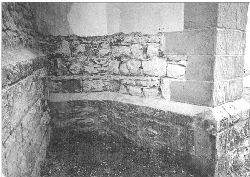
Obr. 8. Valašské Klobouky, děkanský kostel Povýšení sv. Kříže – detail nasazení diagonálního opěrného pilíře na JZ nároží lodi; skladba zdiva svědčí o současném vyzdívání lodi i pilíře. Vpravo kvádřová armatura pilíře, dole soklová římsa, vpravo druhotně přisazené zdivo věže, pohled od Z (foto: R. Vrla 2002).
