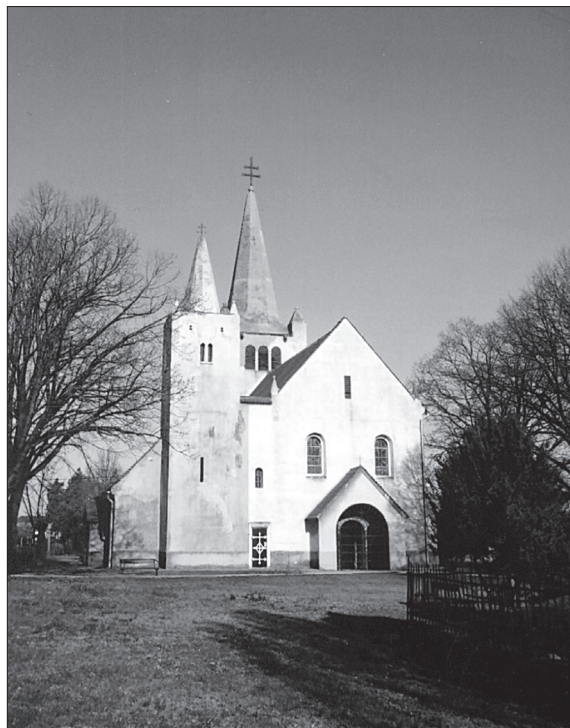
Obr. 1. Kostol v Moste pri Bratislave, súčasný stav fasády.
