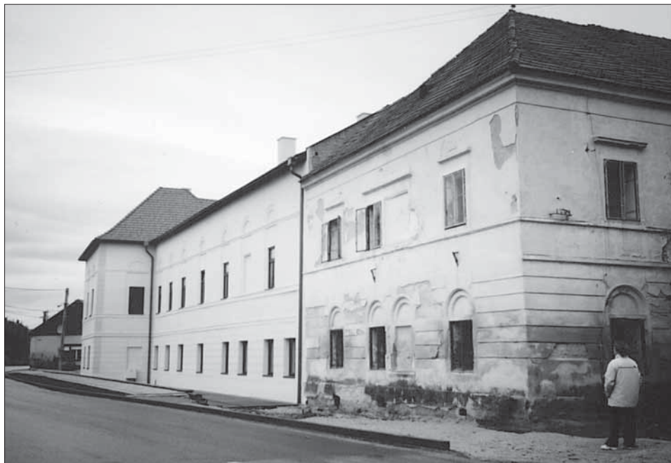
Obr. 1. Kaštieľ v Ostraticiach. Súčasný stav. Skúmaný kaštieľ I. v procese stavebnej obnovy. Foto Z. Ševčíková.
