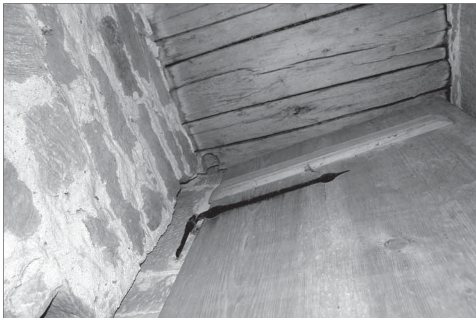
Obr. 4. Pařížov, špaleta vstupu do věže z tribunu s dřevěnými překlady, otvorem pro točnici dveří a kapsou závory. Foto J. Varhaník, 2007.
