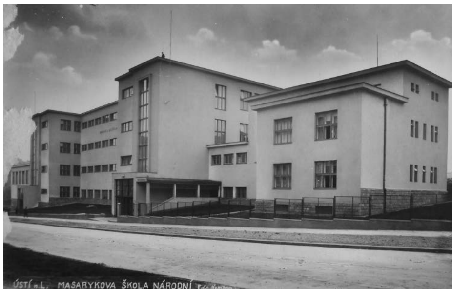
Fotografie nové školní budovy české školy v městě Ústí nad Labem (převzato z Matriky českých škol, O–Z).
