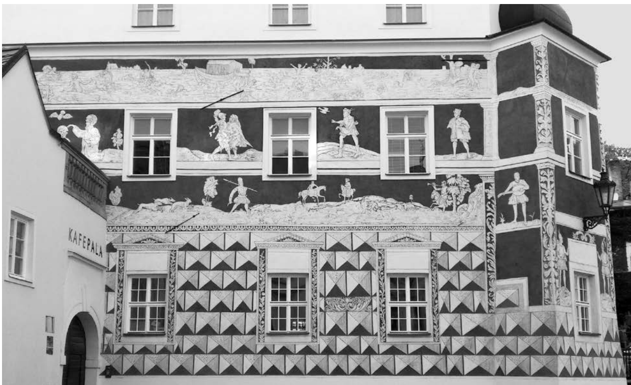
13 – Mikulov, Náměstí, dům č. 24, východní fasáda
