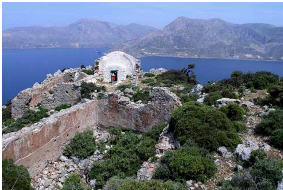
Obr. 9. Télendos, zřícenina budovy velké cisterny na hrotu lokality Kástro. Foto M. Losse, jemuž děkuji za poskytnutí snímku. Abb. 9. Telendos, Ruine des Gebäudes einer großen Zisterne auf der Spitze der Fundstelle Kastro. Foto M. Losse, dem ich für die Überlassung der Aufnahme danke.
