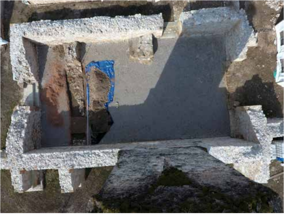
Obr. 31. Pohľad na základové murivo bývalej empory kostola. Foto A. Balogh.
