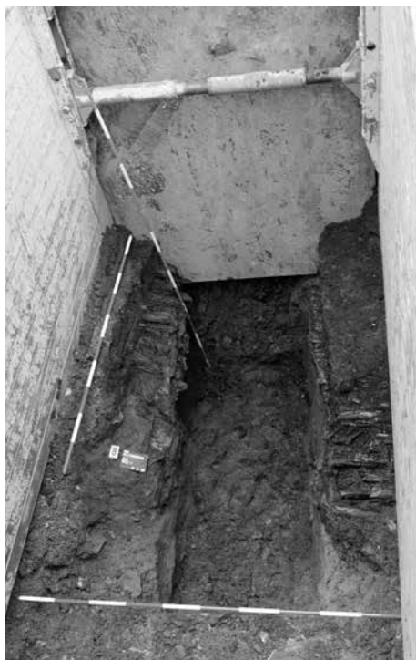
Obr. 2. Hradec Králové, křižovatka ulic Tomkova a Klicperovy, stavba kanalizace, vyrovnání terénu borovými větvemi, 14. století.
