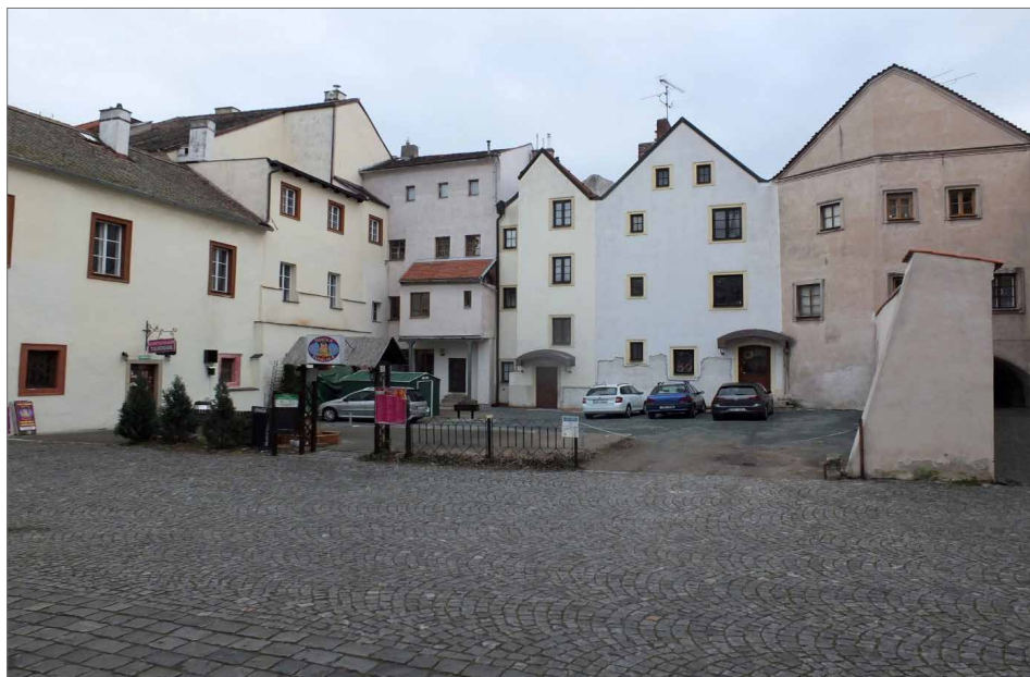
Obr. 11. Pardubice, Pernštýnská ulice, čp. 13. Pohled na dvůr domu čp. 13 z prostoru Wernerova nábřeží. Vpravo jižní obvodová zeď bývalého Císařského mlýna. Foto ze sbírek VČM v Pardubicích.
