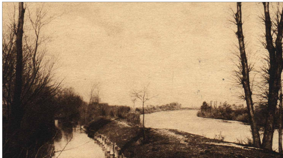
Obr. 2. Pardubice, trať V Úzkém. Kanál Halda (vlevo) probíhal paralelně s tokem Labe (vpravo). Za povšimnutí stojí rozdílná výška hladin obou toků a umělá úprava břehu kanálu. Foto ze sbírek VČM v Pardubicích.
