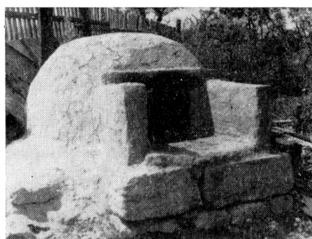
4. Kraněvo. Letní kupolovitá chlebová pec na soklu s ohništěm předsunutým před čelistí pece. Foto: L. Skružný 1962.
