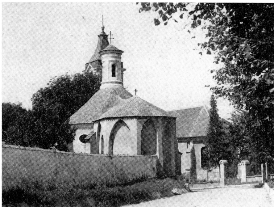
Obr. 1. Holič – loretánska kaplnka. Pohľad na skúmaný objekt od juhovýchodu – v pozadí farský kostol. Foto D. Tóth.
