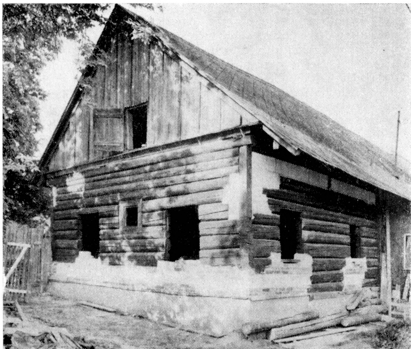
Obr. 1. Lučice čp. 2 (okr. Klatovy), celkový pohled na obytnou část domu po sejmutí hliněné omazávky a náhradě narušených prvků roubené konstrukce. Stav 1982.
