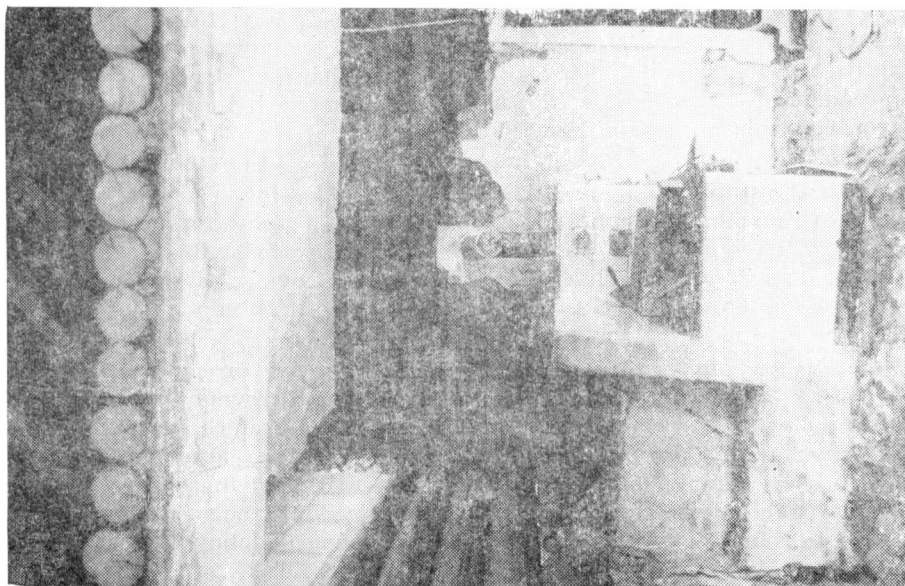
Obr. 2. Lučice čp. 2 (okr. Klatovy), pohled do kouta obytné místnosti s otopným zařízením (odleva pec, vytápěná z mladší černé kuchyně, sporák a vstup ze síně). Nahoře čela stropních povalů, uříznutých v polovině místnosti nad hraněným stropním trámem. Stav 1982.
