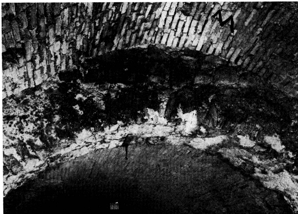
Obr. 5. Kamenný podklenutý pás v spodnom podlaží objektu Nálepková 16, ktorý nesie priečku horného podlažia. Nad vrcholom oblúka je viditeľná pôvodná úroveň podlahy horného podlažia. Klenba je ranorenesančná. Foto: J. Schramek.
