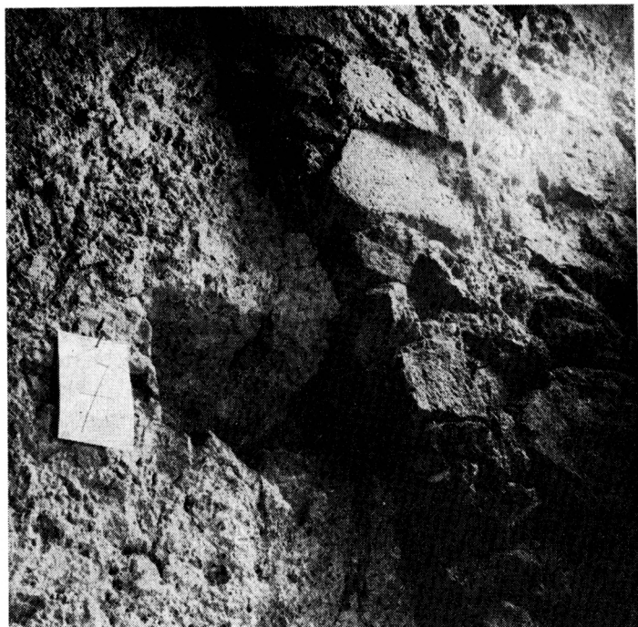
Obr. 8. Prepoštská 11 — kamenný podklenutý pás spodného podlažia objek- tu, druhotne podmurova- ný v prvej tretine 15. sto- ročia. Foto: V. Kamenic- ká.
