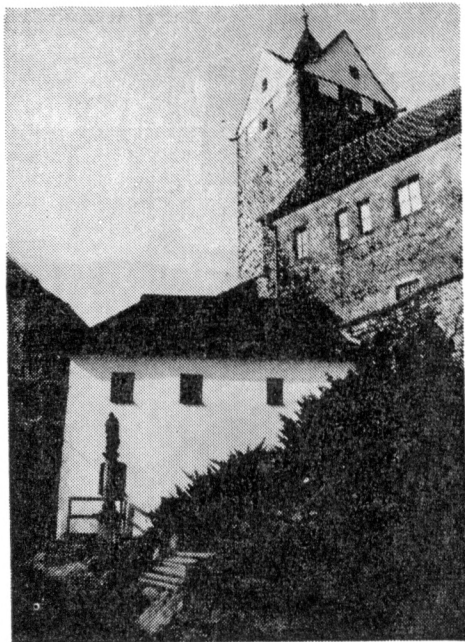
Obr. 5a, b. Hrad Loket — hradní věž před a po poslední úpravě, která nevhodně zvýraznila historickou zazdívkou proluk cimbuří a nahradila plastickou prejzovou krytinu Tegolou.
