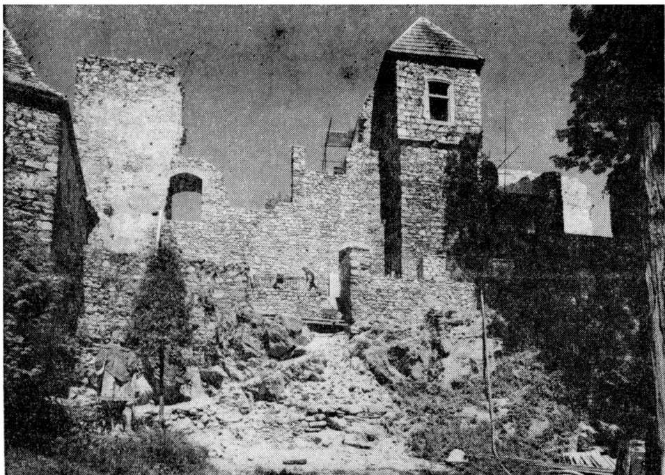
Obr. 1. Hrad Klenová u Klatov — příklad rekonstrukce nedávno zřícené části hradní kulisy, s vložením stabilizační dozdivky, pro níž byl hledán tvar, navazující na romantickou úpravu z 19. století.
