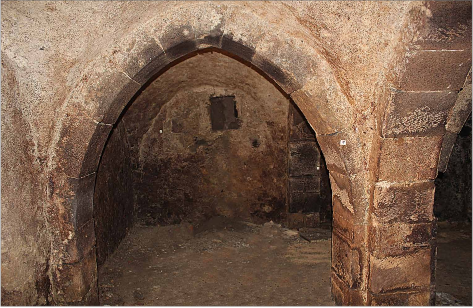
Obr. 17. Pohľad do interiéru smerom na východ.
