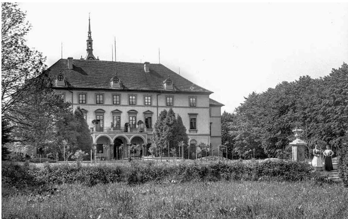
7 – Zámek ve Zdechovicích před novodobou devastací. Zahradní průčelí. Východočeské muzeum v Pardubicích, inv. č. FA-F2-00373
