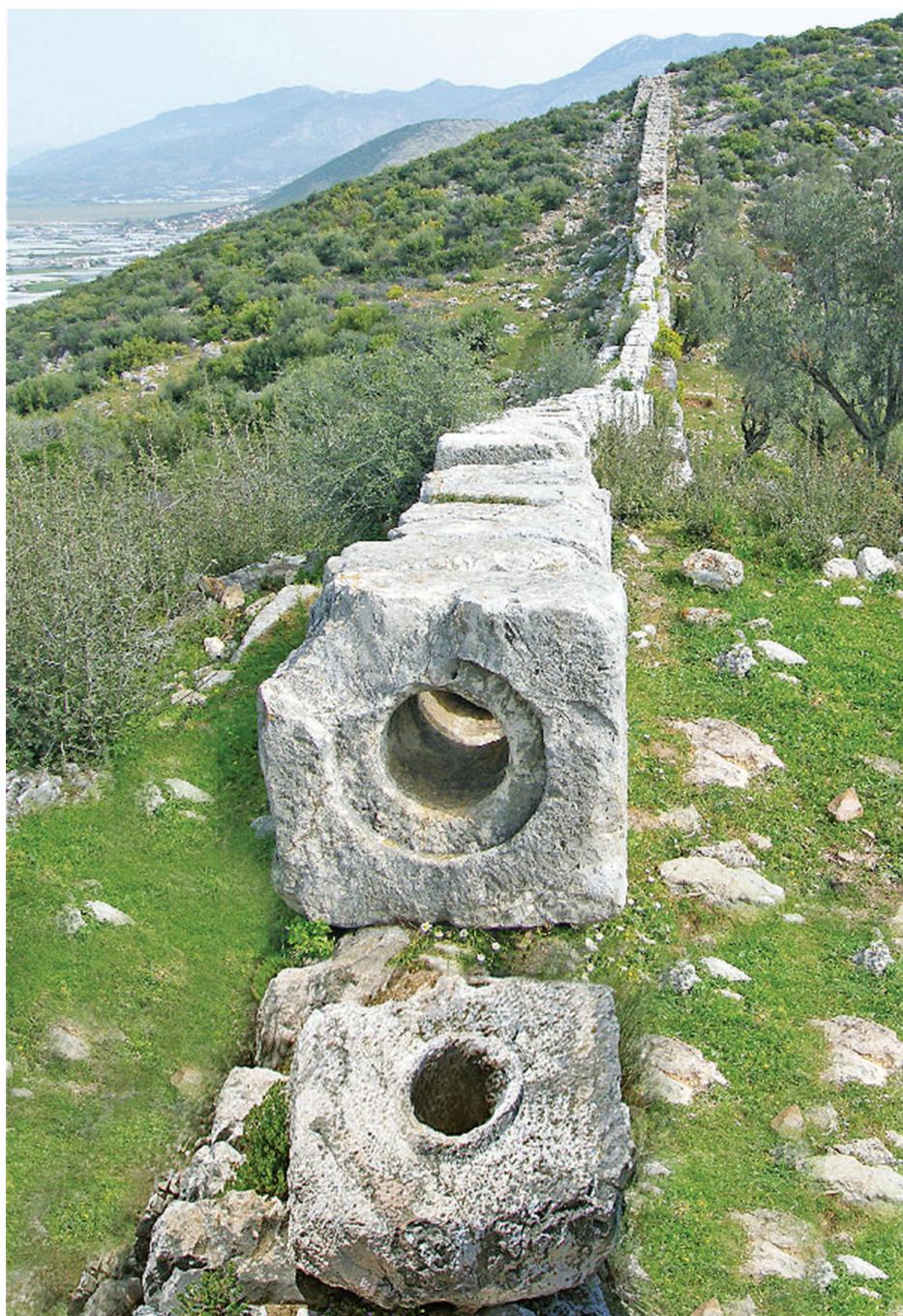
Obr. 22. Uzavreté kamenné bloky tvoriace potrubie sífónu z akvaduktu v Patara (v Turecku). Zdroj: https://commons.wikimedia.org/wiki/File:Canalisation_en_pierre_de_l%27aqueduc_siphon_de_Patara_en_Turquie.jpg
