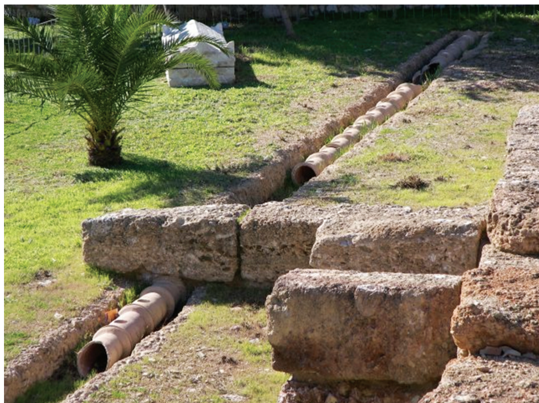
Obr. 8. Časti/segmenty terakotových rúr Peisistratovho akvaduktu uložené v kanáli. Zdroj: https://ancientwatertechnologies.com/2012/12/31/water-technologies-of-ancient-athens-greece/
